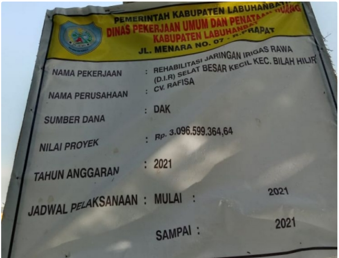
Ket.Foto: Plang Proyek Rehabilitasi Jaringan Irigasi Rawa (DIR)
