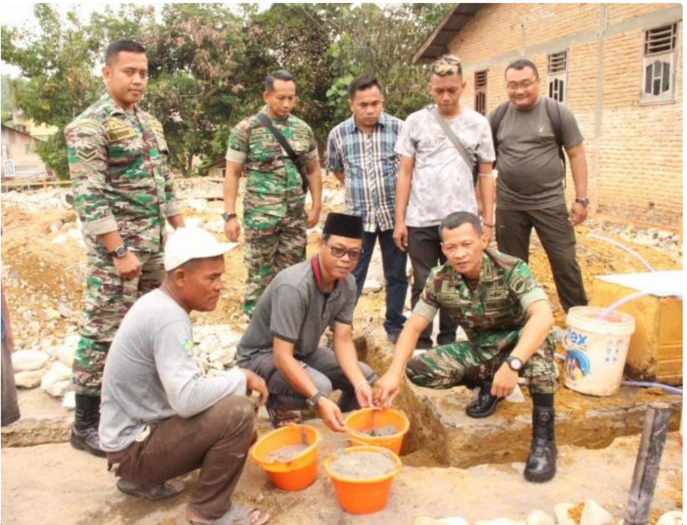
Dandim 0209/LB Letkol Inf Yudy Ardiyan Saputro didampingi Pasi Intel Lettu Inf Aswin meletakkan batu pertama pembangunan rumah warga binaan
